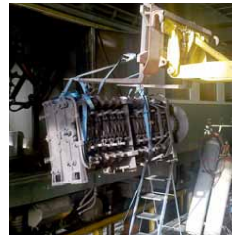
Ausbau des Schaltwerkes
