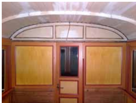
Die alte Decke kommt zum Vorschein
