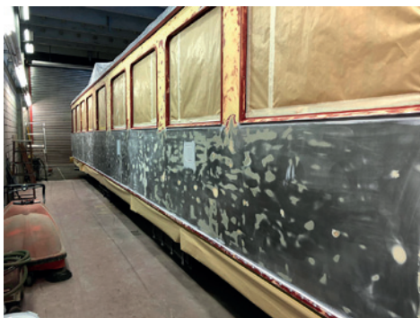
Der Br10 ist für den neuen Anstrich vorbereitet
