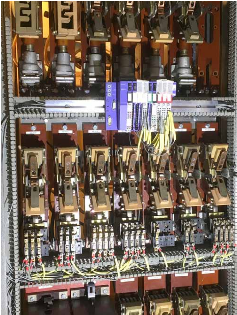
Die Verdrahtung an den Hüpferschranken kommt voran
