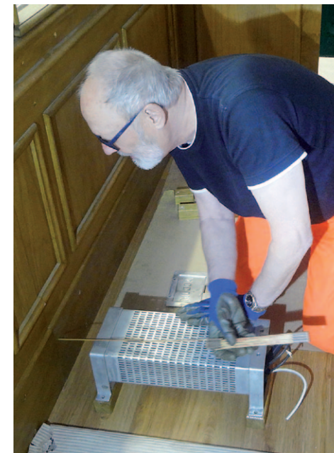
Sepp beim Montieren der Heizkörper
