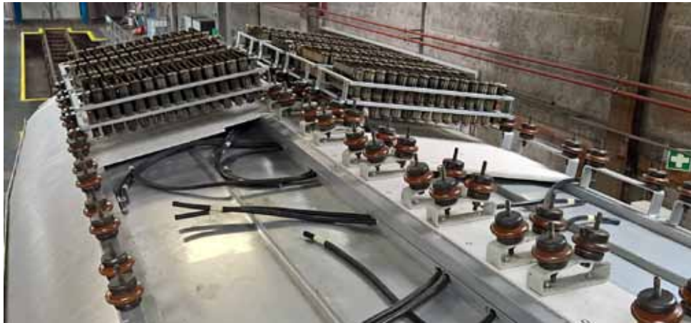
Die Widerstandspakete werden auf dem Dach installiert und verkabelt
