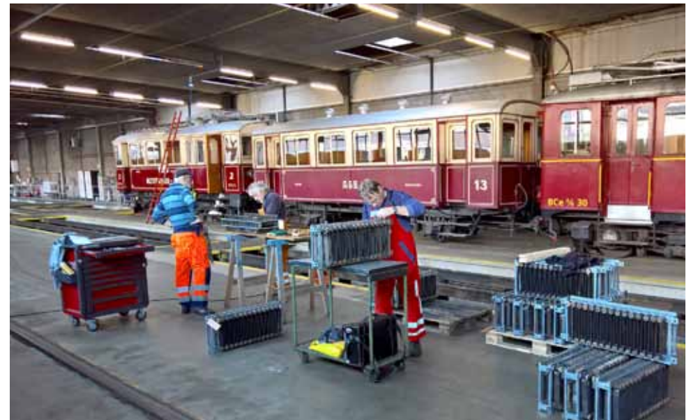
Die Montage der Widerstandspakete aufs Dach wird vorbereitet
