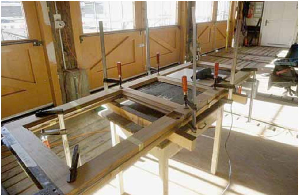
Die Schiebetüren werden komplett neu gebaut
