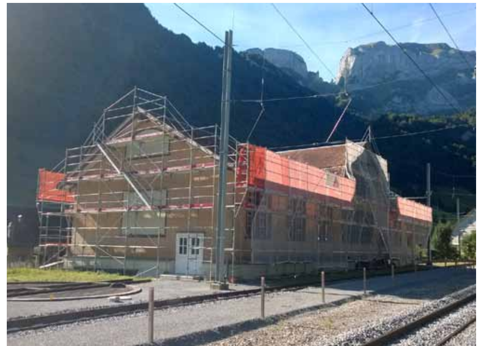
Noch verdeckt das Gerüst die getätigten Arbeiten am Depot
