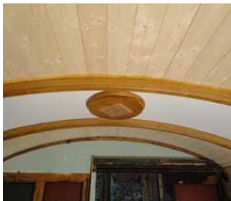
Ein erstes Element der Deckenverkleidung mit einem gedrehten Lüftersockel ist montiert und gestrichen
