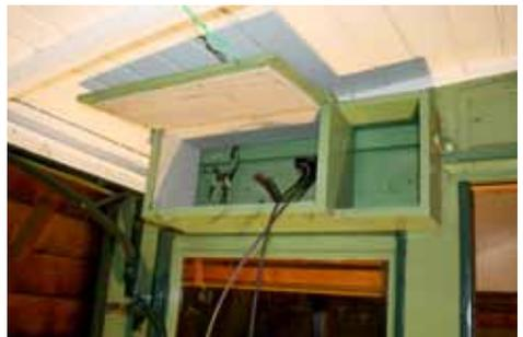
*In dieses Gehäuse werden Schalter für Licht und Heizung und die Sicherungen eingebaut.*
