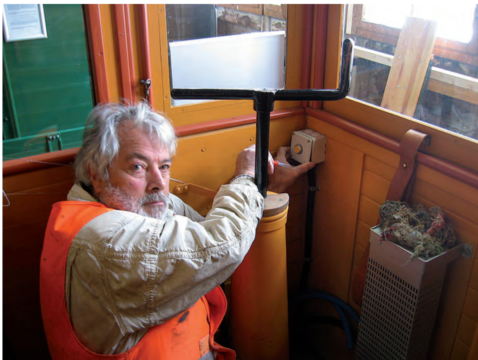
Walter Eisenhut bei der Montage der Totmannsteuerung.
