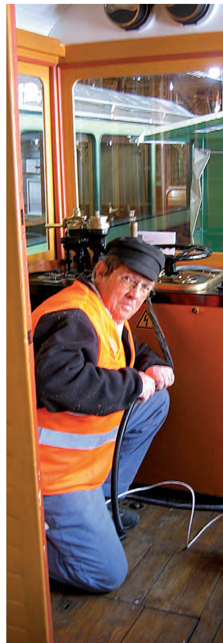
Jörg Künzle zieht die Kabel ein.
