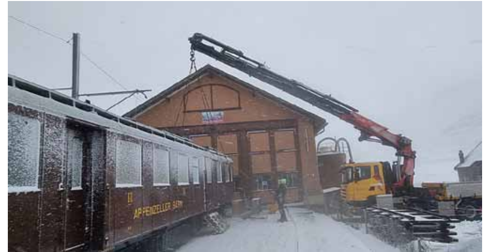
Die nachfolgenden Fotos zeigen den Ausbau des Dachdeckels mit Kühler, die Trennung von Dieselmotor und Generator sowie den Ausbau aus dem Triebwagen mittels Kran einer Spezialfirma vor dem Depot Wasserauen.
